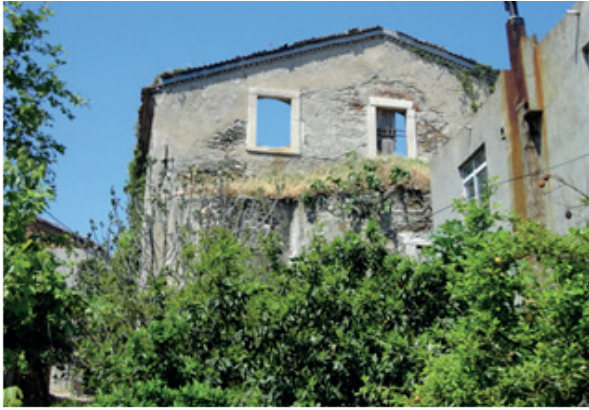
Şekil 12. Yapının Doğru Cephesi
