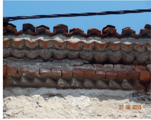
Şekil 13. Yapının Tuğla Kirpi Saçakları
