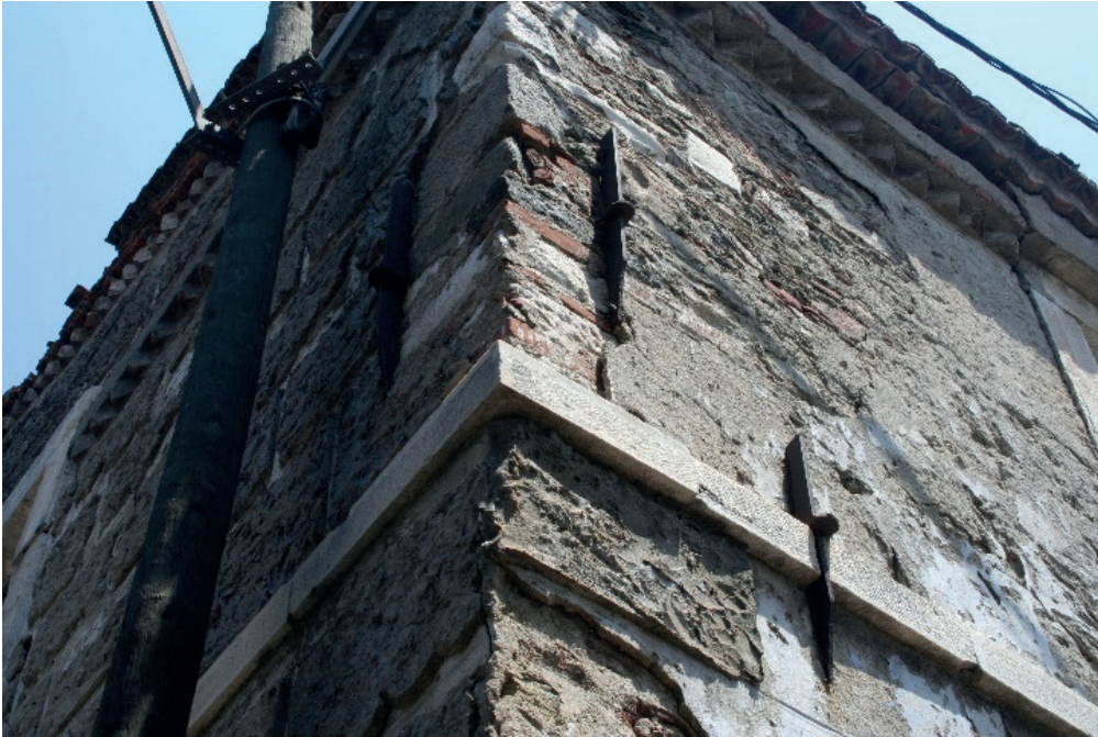
Şekil 10. Cephedeki Metal Kılıçlar
