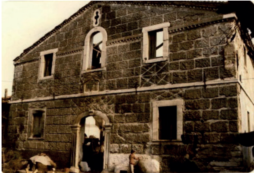
Şekil 1. Yapının 22.09.1987 Tarihli Giriş Cephesi Fotoğrafı (BKVKBK arşivi)
