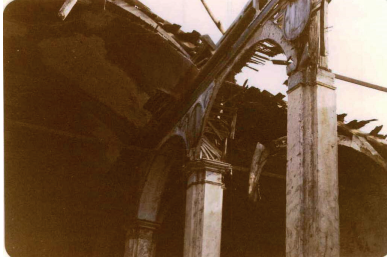
Şekil 20. Ahşap Sütunlar Arasında Bağdadi Çıtası Üzeri Sıva ile Oluşturulmuş Kemerler (BKVKBK arşivi)
